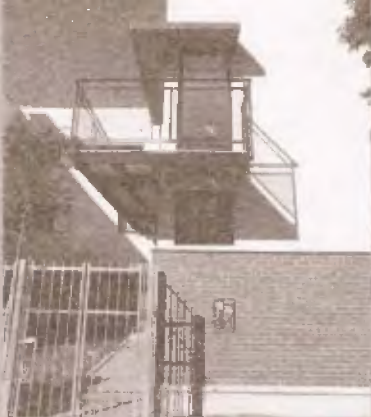
LES HABITATIONS SAINT-AMBROISE, MONTRÉAL PEARL, PODDUBIUK, ARCHITECTES (L'O.E.U.F.) CLIENT : LES HABITATIONS SAINT-AMBROISE
