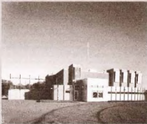
LA STATION D'ÉPURATION DES EAUX DE TERREBONNE TERREBONNE BIRTZ, BAZIN, ARCHITECTES CLIENT : VILLE DE TERREBONNE
