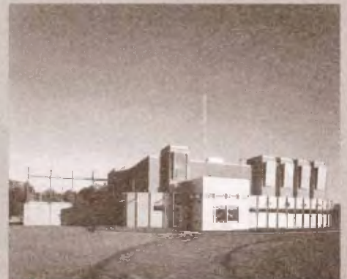
LA STATION D'ÉPURATION DES EAUX DE TERREBONNE TERREBONNE BIRTZ, BAZIN, ARCHITECTES CLIENT : VILLE DE TERREBONNE
