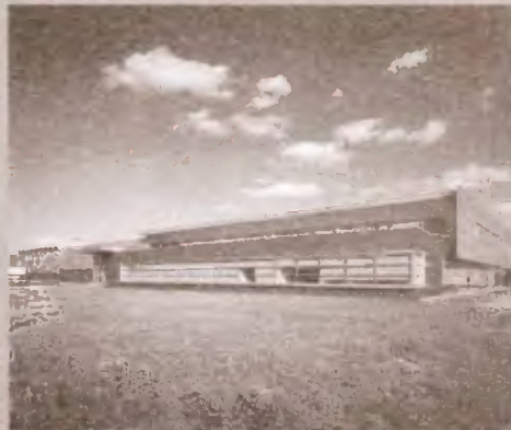
LE SIÈGE SOCIAL DES INDUSTRIES SCHLUMBERGER TROIS-RIVIÈRES BIRTZ, BAZIN, ARCHITECTES CLIENT : INDUSTRIES SCHLUMBERGER
