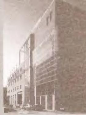
LE PAVILLON DE DESIGN DE L'UNIVERSITÉ DU QUÉBEC À MONTRÉAL, MONTRÉAL DAN S. HANGANU, ARCHITECTE CLIENT : UNIVERSITÉ DU QUÉBEC À MONTRÉAL
