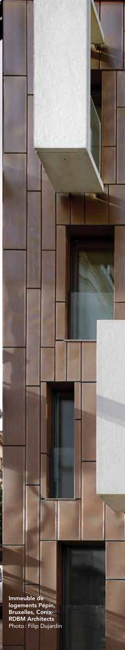
Crèche Saint-François et logements, Bruxelles, O2 architectes Photo: Filip Dujardin
