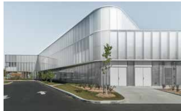
▲ Bibliothèque de Drummondville, Chevalier Morales architectes DMA architectes Photo : Chevalier Morales architectes
