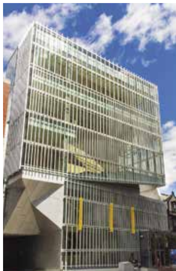
Jodoïn Lamarre Pratte architectes & Atelier TAG // Musée des Beaux-Arts de Montréal // Pavillon pour la Paix Michal et Renata Hornstein
