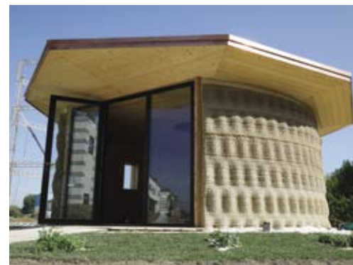
◀ Gaia, une maison-modèle en terre, « imprimée » en 3D grâce à la technologie conçue par la firme italienne WASP Photos : WASP
