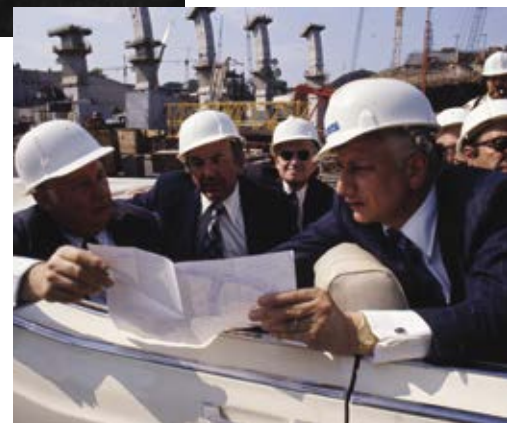
Roger Taillibert sur le chantier du Parc olympique de Montréal en 1975. Photo : Régie des installations olympiques
