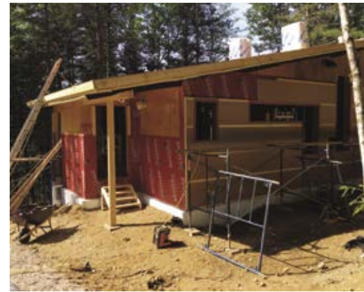
Auvergne laboratoire vivant, Sainte-Christine-d'Auvergne, Richard Trempe architecte. Photo : Richard Trempe
