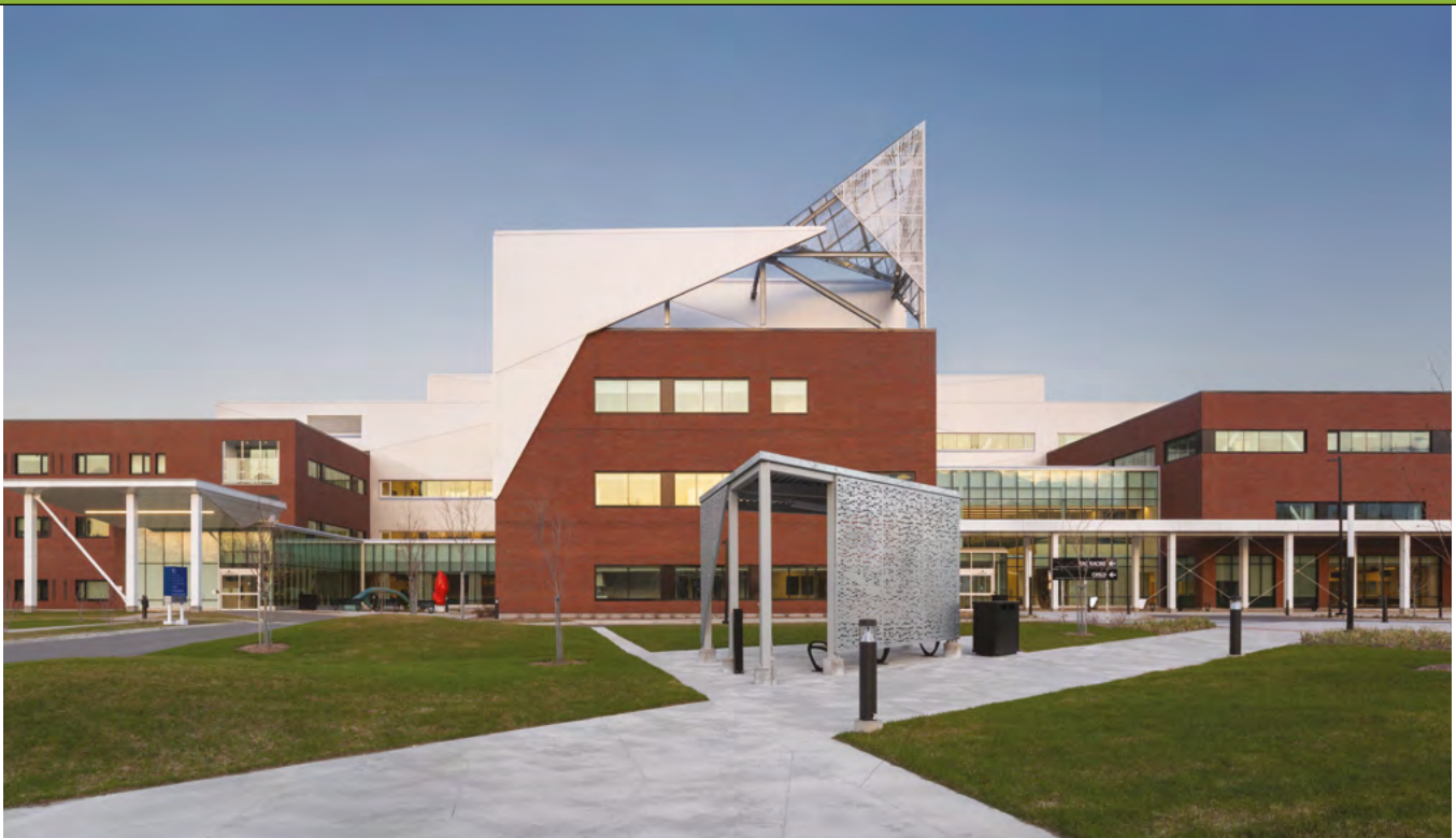
▲ Hôpital de Baie-Saint-Paul, Groupe A et Lemay en consortium Photo : Stéphane Groleau
