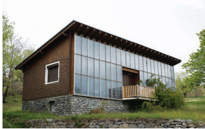
◀ Maison Trombe expérimentale (1967-1968), Odeillo, Pyrénées-Orientales (France) Photo : Corinne Leclerc
