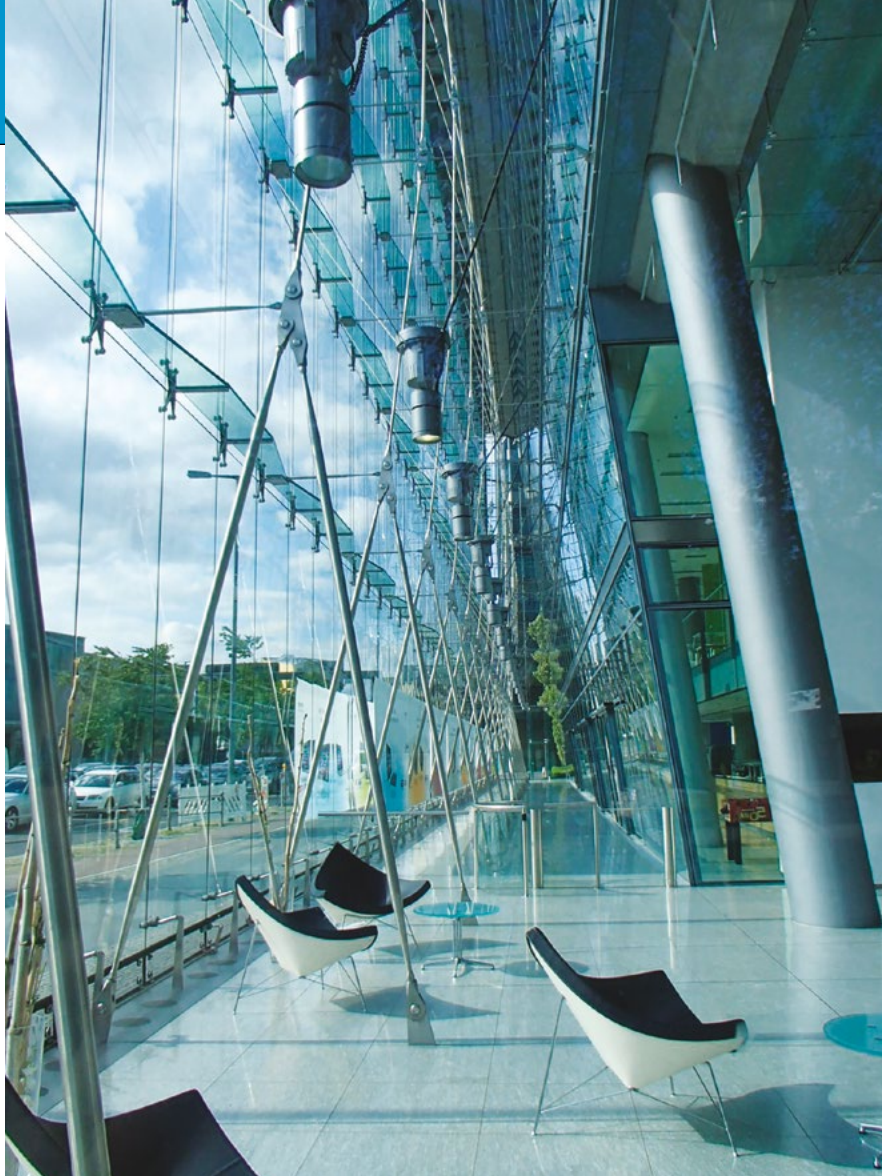
▲ Mur double peau à large cavité (ci-dessus) avec espace transitoire (Centre Sony, Berlin, 1998), et mur à mince cavité (ci-contre) vers 1960. Photos : Richard Trempe ▶
