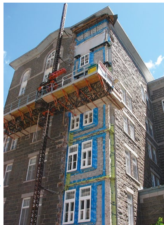
Réfection partielle de façade. ▶ Trempe Architecte Photo: Richard Trempe
